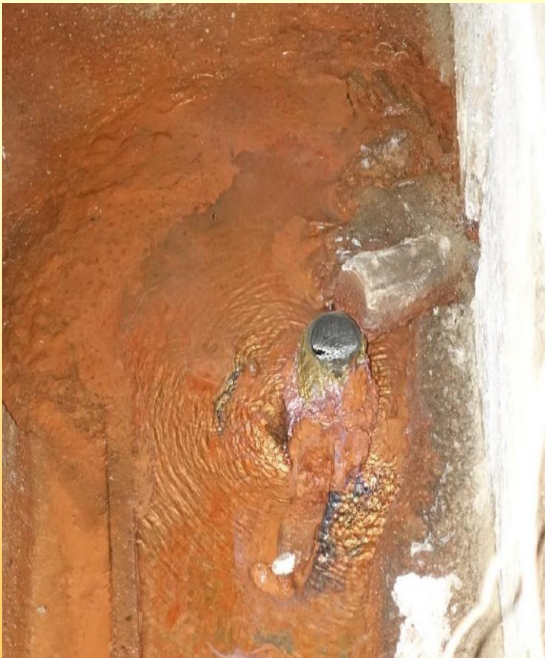
Další výzva – havarovaný vrt V2 Bystřany (1897)
